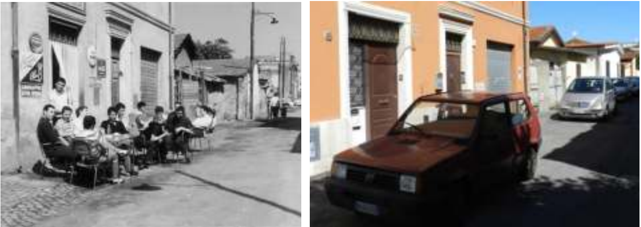
Fig. 7-8: Accattone, 1961/2016. La bassa densità della borgata risulta ancora visibile, ma la vocazione dei luoghi è oggi tipicamente residenziale.
