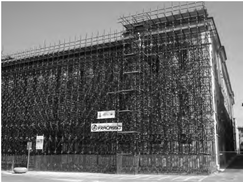
Ponteggi in un edificio del Centro Storico de L'Aquila
