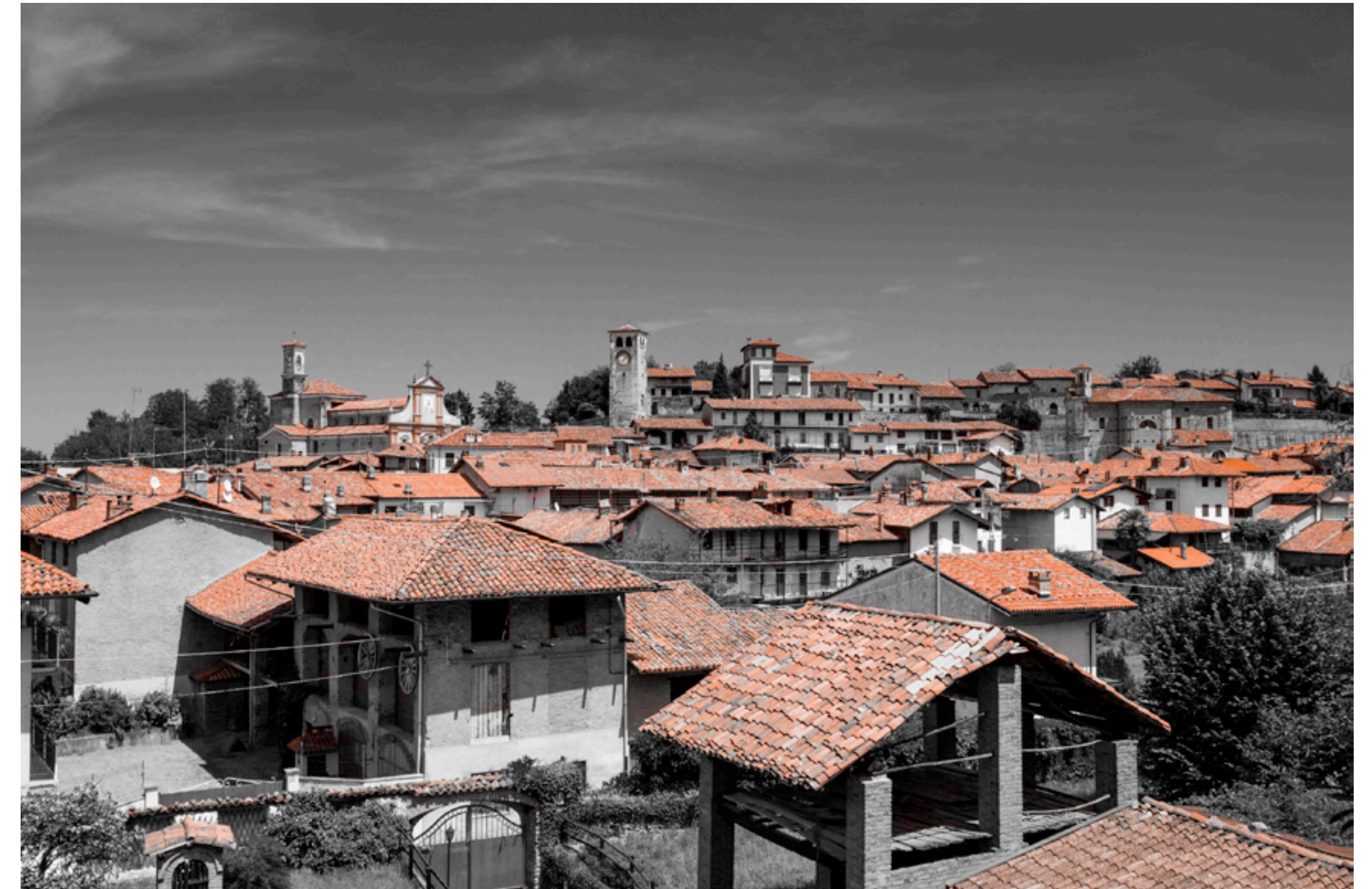
Fig. 1 - Il paese di Magnano nella contrapposizione tra il ricetto emergente con la sua torre e la chiesa parrocchiale e la sottostante volumetria irregolare degli edifici rurali (foto di Massimo Rama).
