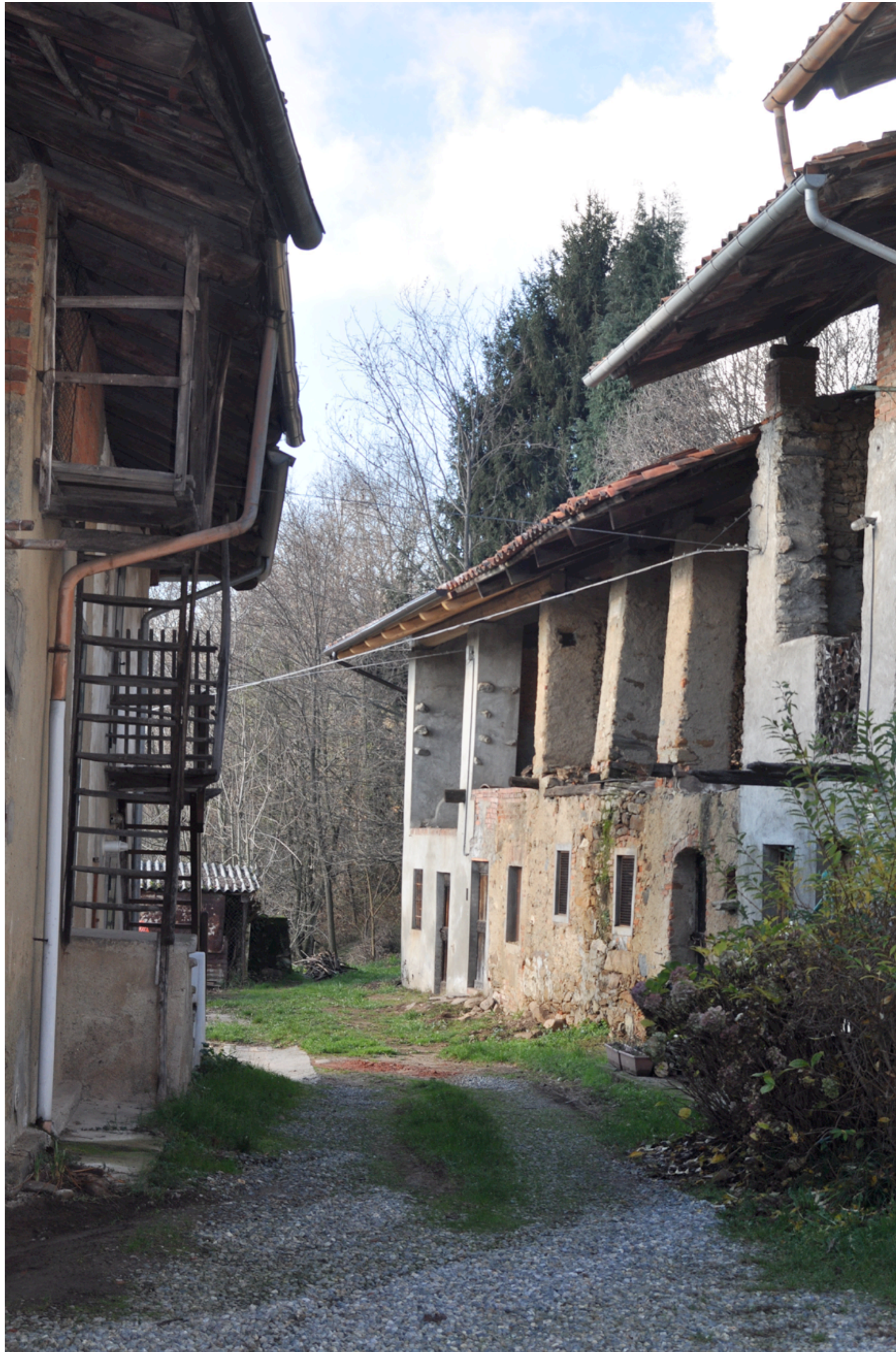
Fig. 20 - 21 - Stato attuale di un altro edificio in frazione Piletta. Il rilievo ne è risultato complesso a causa dei forti dislivelli, degli sbandamenti delle murature e delle coperture, permettendo tuttavia di cogliere gli elementi significativi per proporre soluzioni di recupero.
