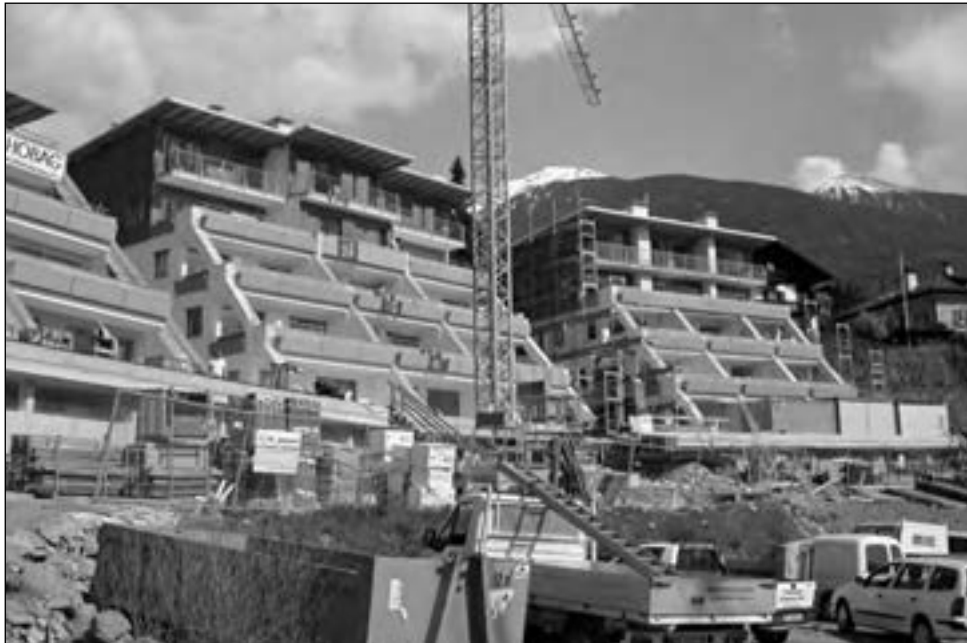
Cantiere di edilizia residenziale bioclimatica a Bressanone
