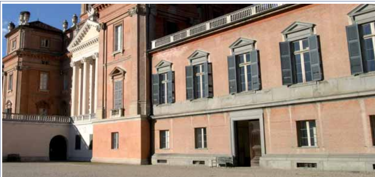
Ingrandimento a levante, al primo piano l'Appartamento dei principini.
