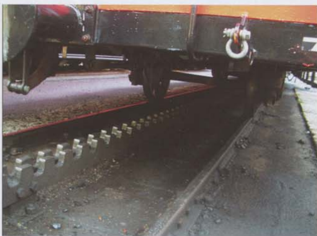
Fig. 1 - Esempio di cremagliera: applicazione in area montana (Austria).
