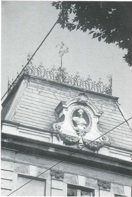
FIG. 4. Palazzina Avondo, Torino: particolare.
